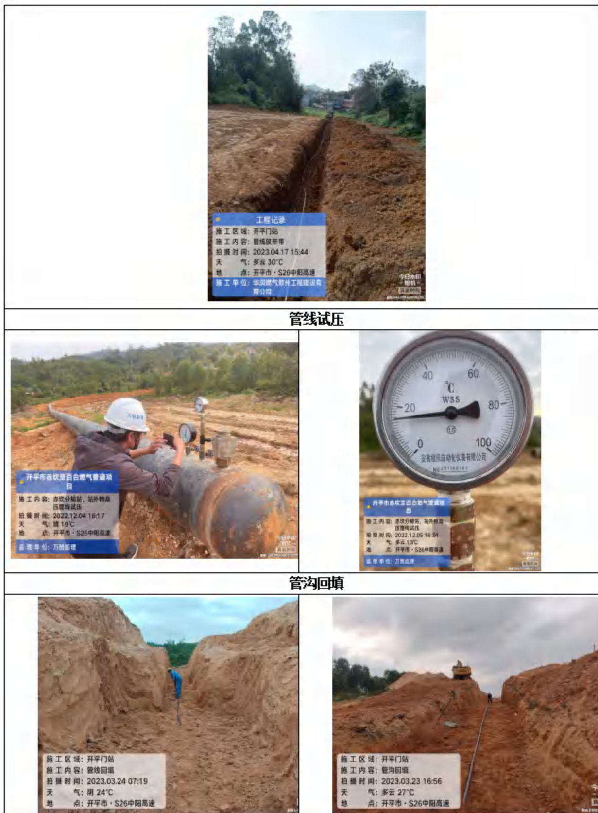
图 2.6-3 施工期现场图
