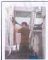
喷漆、浸漆废气处理前
