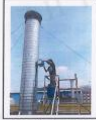
网版上胶、烤网版、印刷、烘干废气排放口
