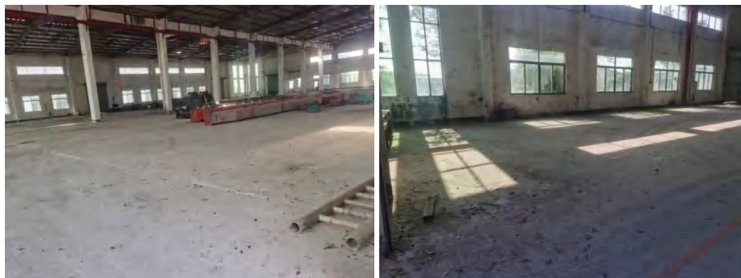
图 4.2.5-1 项目厂房现场照片
