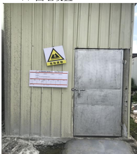
9、危险废物暂存间
