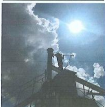
图6 水稳剂生产废气排气筒采样口(处理后)③
